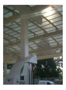
BP a décidé de passer à l'acte en lançant un programme ambitieux: "Harmony". Il s'agit d'intégrer des panneaux solaires dans l'auvent des stations services afin de générer de l'énergie électrique d'origine solaire et couvrir ainsi les besoins en énergie des pompes et de l'éclairage des pistes. Les modules, qui bénéficient de la nouvelle technologie dite "en couche mince". sont intégrés directement dans le toit des auvents. Translucides, ils permettent le passage de la lumière naturelle.
