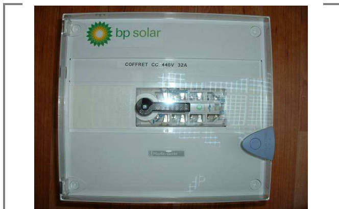
Figure 11. Vue coffret de sectionnement courant continu REF.270112
