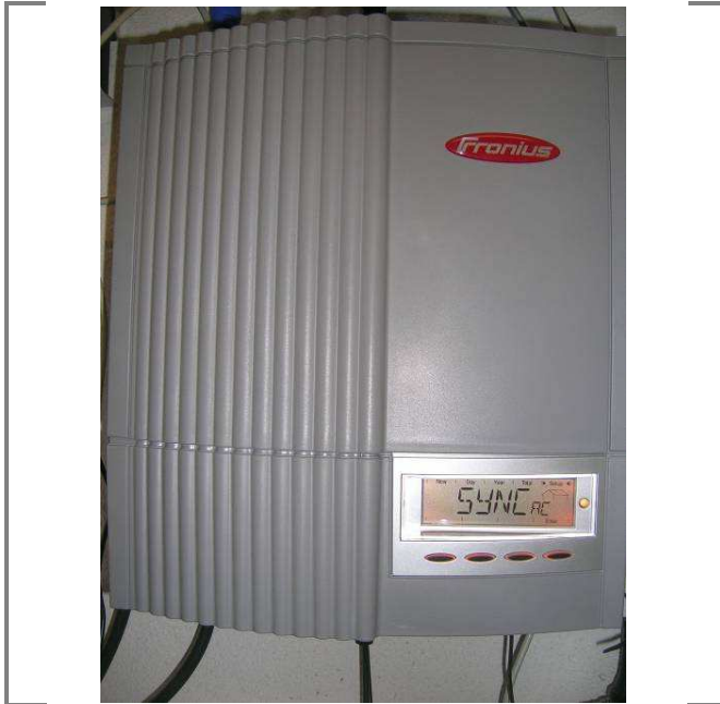
Figure 19. Onduleur en attente réseau.
