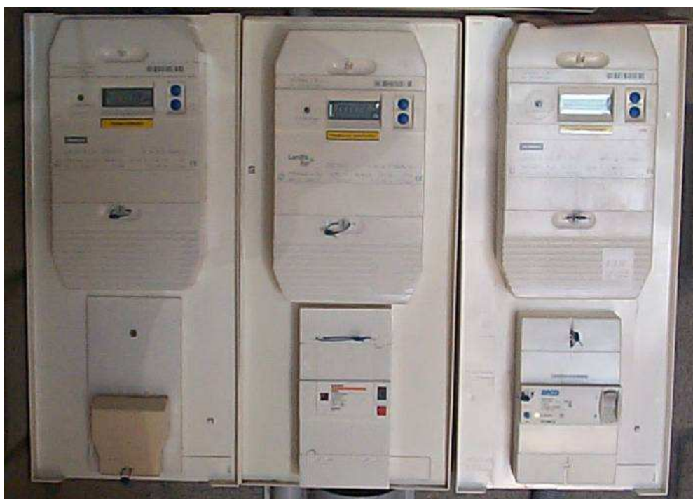
Figure 15. Exemple d'un point de livraison d'énergie (limite de concession).
