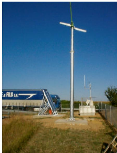
Les générateurs hybrides installés sont réalisés avec du matériel de qualité et de forte résistance aux conditions climatiques (tempête, air salin,...), ne nécessitant qu'une intervention annuelle de maintenance par du personnel technique.
