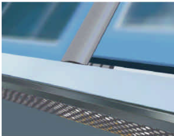
Figure 23. Etape 14 : positionnement du joint vis à vis du module
