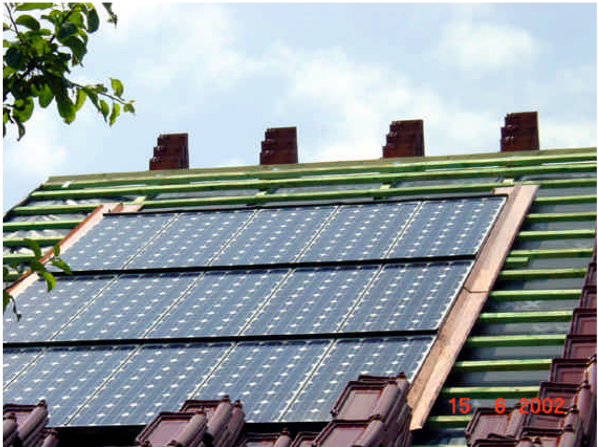
Figure 1. Vue d'ensemble d'un système Intégra en cours de pose
