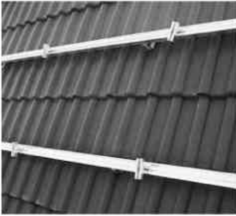
Figure 15. Positionnement des serreurs
