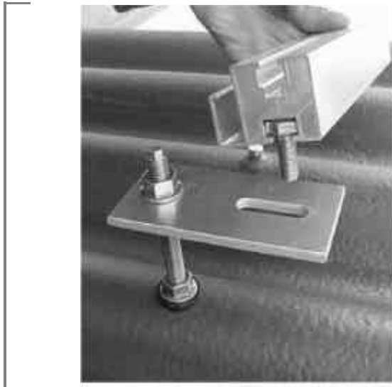
Figure 9. Positionnement des rails
