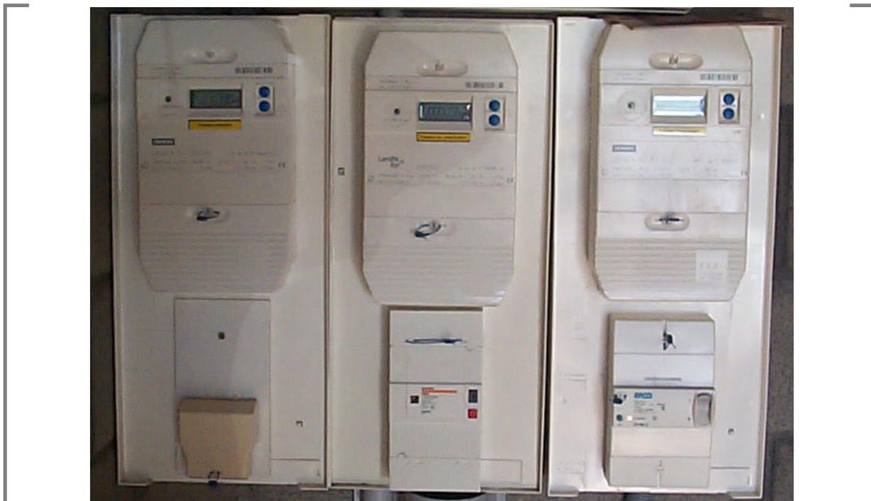
Figure 8. Exemple d'un point de livraison d'énergie (limite de concession).
