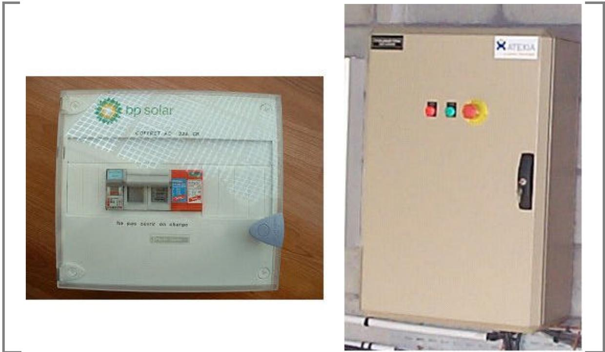
Figure 6. Coffret « TGBT AC » type, pour particulier (à gauche) ou pour client industriel (à droite).
