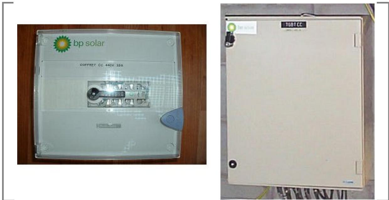
Figure 5. Coffret TGBT CC type, pour particulier (à gauche) ou pour client industriel (à droite).
