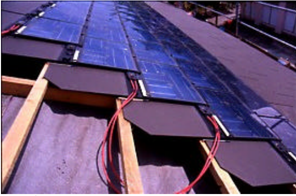
Connexion des ardoises photovoltaïques
