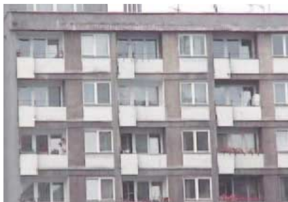
Illustration 2.12 - Bâtiment résidentiel en béton cellulaire construit en Pologne entre 1965 et 1985.
