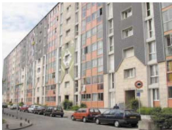
Illustration 4.3 - Exemple de rénovation de logements sociaux.
