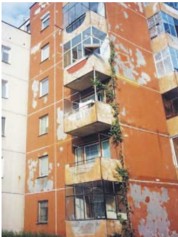
Illustration 2.7 - Exemple de désordre constaté dans les bâtiments préfabriqués.
