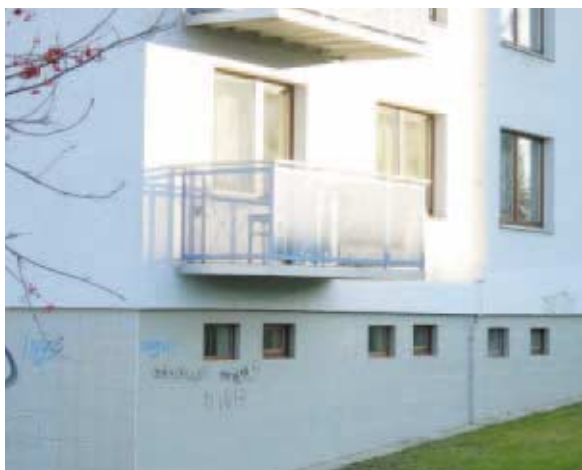
Illustration 2.6 - Immeubles de la période 1961-1990.
