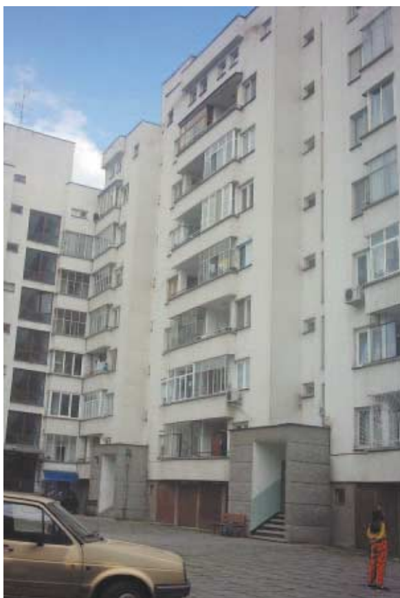
Illustration 2.9 - Exemple de construction en béton armé en Bulgarie
