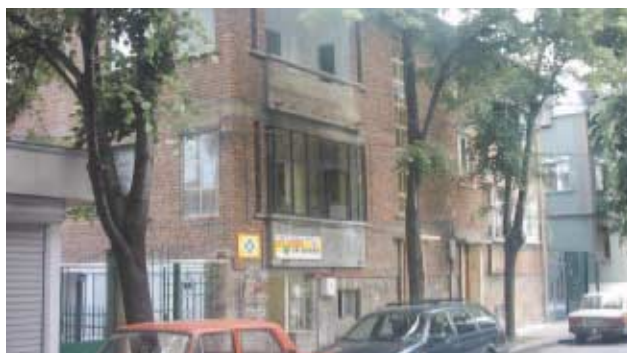
Illustration 2.10 - Exemple de construction massive à gros murs de briques.
