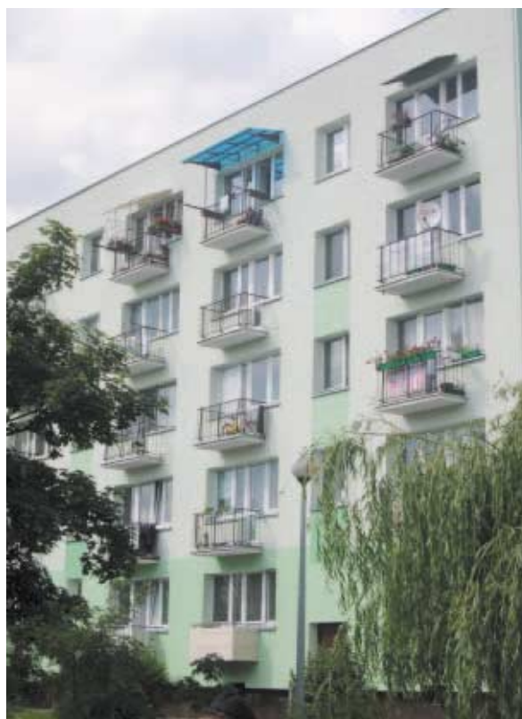
Illustration 4.8 - Exemple de rénovation d'immeuble à Legionowo.
