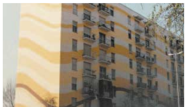
Illustration 2.1 - Logements sociaux avant et après rénovation (pose de revêtement isolant).
