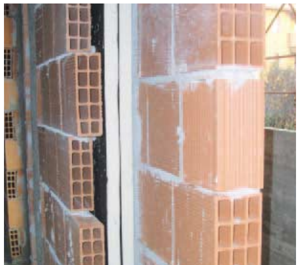
Illustration 5.1 - Exemple de normes d'isolation supérieures dans la construction d'un nouvel immeuble résidentiel à Carugate.
