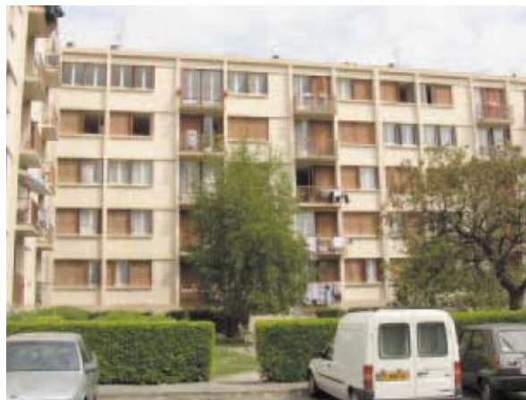
Illustration 4.4 - Exemple d'immeuble à Échirolles.
