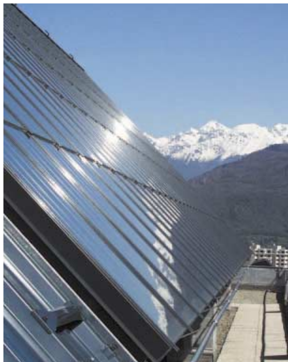
Illustration 4.6 - Exemple d'utilisation d'énergie renouvelable dans un immeuble.
