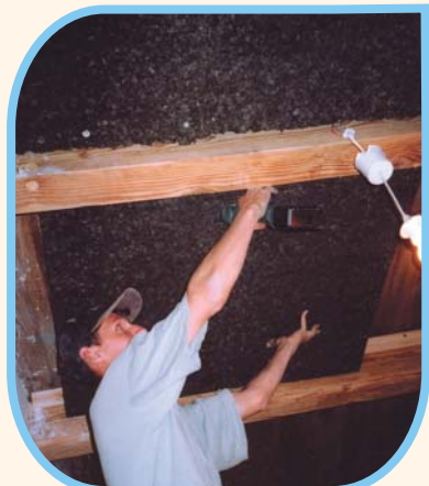
isolation des combles
