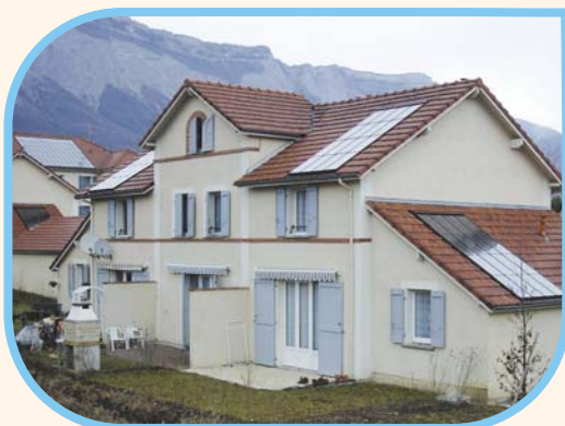
panneaux solaires thermiques
