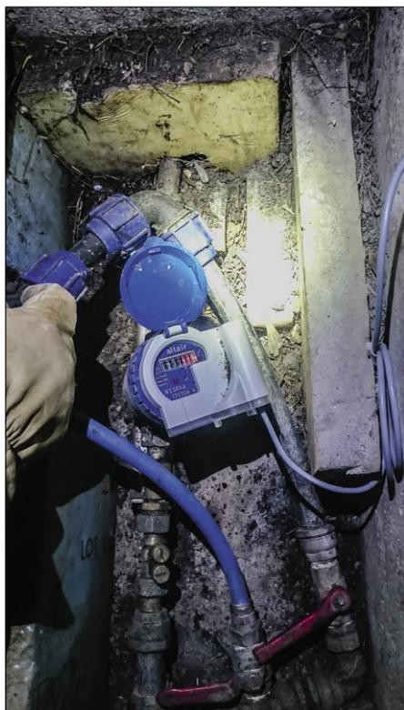
Figure 1. Exemple in situ d'émetteur d'impulsions.
