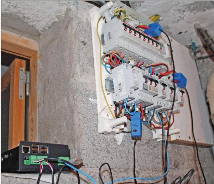
Figure 1. L'installation du SmartPi par un technicien qualifié (je le suis. Vraiment).
