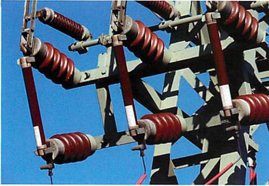
Fig. 3.9 Fusibles pour utilisation extérieure
