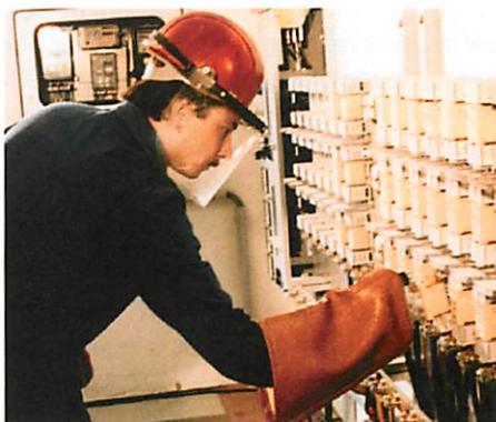
Fig. 12.1 Manipulation d'éléments de remplacement de système de fusibles NH en charge
