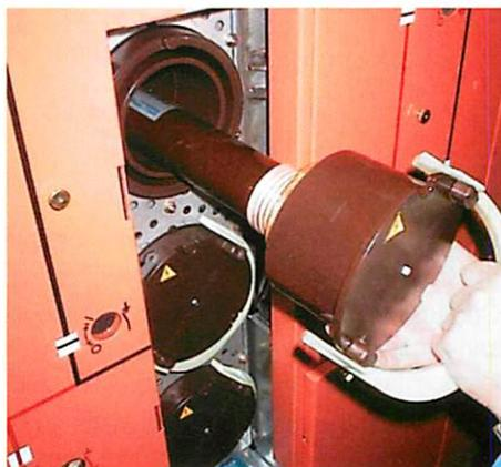
Fig. 3.8 Puit-fusible (fourreau) HT
