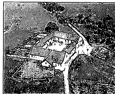
Fig. 3 : Locaux affectés à l'exploitation agricole.
